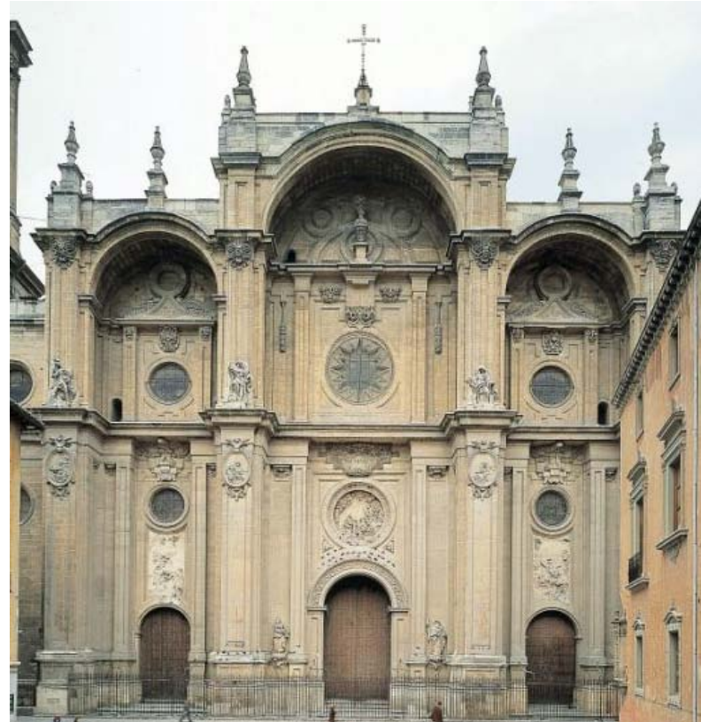
Fachada de la Catedral de Granada Terminada en 1667
